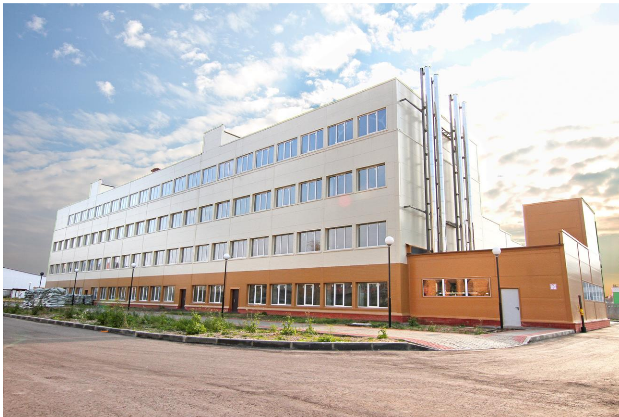
Наш новый производственно-складской корпус
